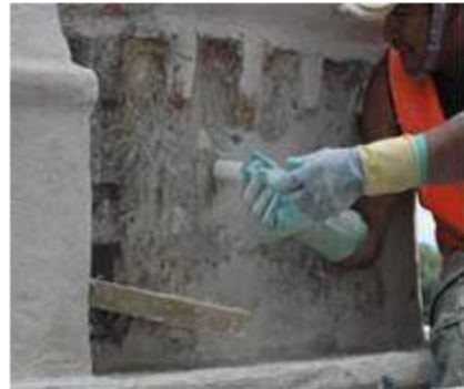
CONSOLIDACIÓN DE APLANADOS ORIGINALES
