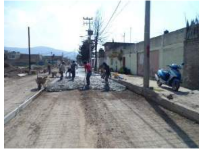
FABRICACIÓN DE GUARNICIONES Y BANQUETAS, COLADO CON CONCRETO PREMEZCLADO
