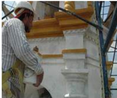
PINTURA A LA CAL PIGMETADA CON COLORES MINERALES
