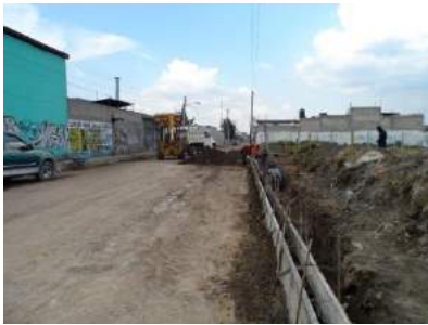
FABRICACIÓN DE GUARNICIONES Y BANQUETAS, COLADO CON CONCRETO PREMEZCLADO
