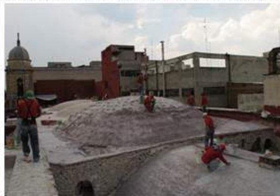
REINTEGRACIÓN DE CAPA DE COMPRESION
