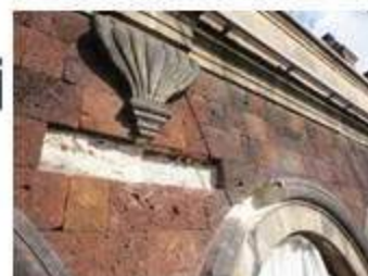
REINTEGRACIÓN DE MOLDURAS DE CANTERA
