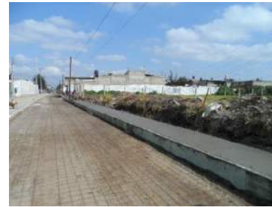
COLADO CON CONCRETO PREMEZCLADO, ACABADO RALLADO
