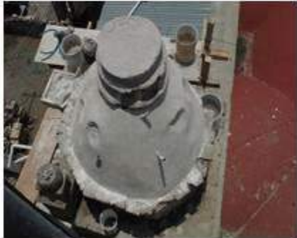
RECTIFICACIÓN DE CUPULÍN DE TORRE CAMPANARIO DEL SIGLO XVI
