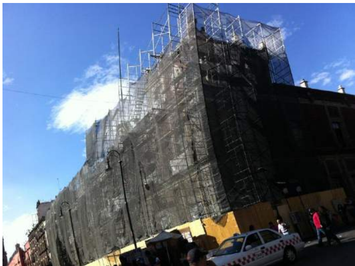
VISTA DURANTE LOS TRABAJOS
