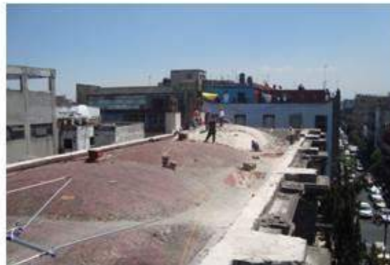
LIBERACION DE ENLADRILLADOS DETERIORADOS
