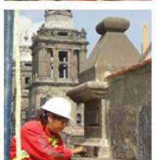
PROCEDIMIENTO DE REINTEGRACIÓN DE PINÁCULO DAÑADO.
