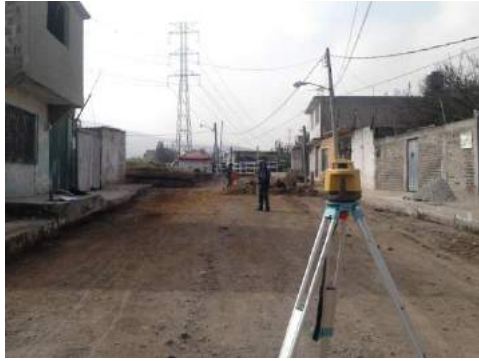
TRAZO Y NIVELACIÓN CON BASE A PROYECTO
