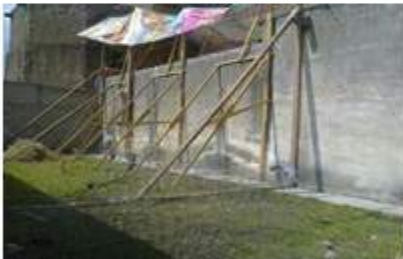
APUNTALAMIENTO DE MUROS
