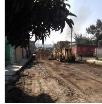
EXCAVACIÓN POR MEDIOS MECÁNICOS PARA ALCANZAR NIVELES DE PROYECTO
