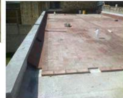
ENLADRILLADO TRATADO CON JABÓN Y ALUMBRE
