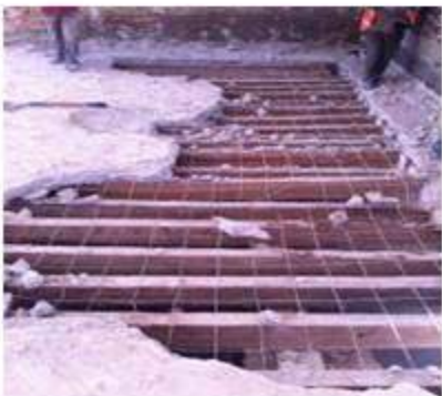
LIBERACIÓN DE LOSA EN MAL ESTADO
