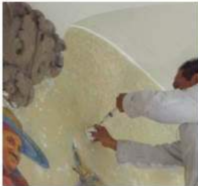
INYECCIÓN EN ZONAS CON DESPRENDIMIENTOS.
