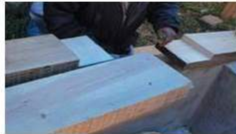
VIGAS DE ARRASTRE
