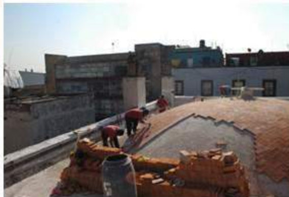
INTEGRACIÓN DE ENLADRILLADO
