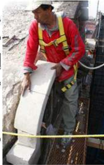
REINTEGRACIÓN DE MOLDURAS DE CANTERA
