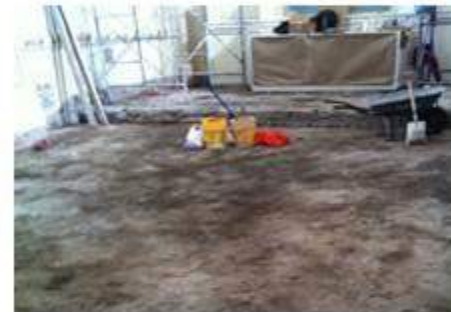
TRABAJOS EN PISOS
