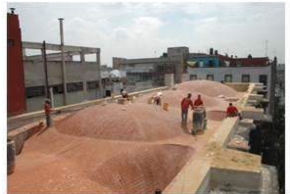
ASPECTO FINAL DE TRABAJOS EN CUBIERTAS
