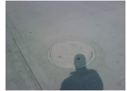
COLADO CON CONCRETO PREMEZCLADO, ACABADO RALLADO
