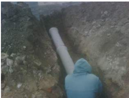
SUMINISTRO Y COLOCACIÓN DE DRENAJE
