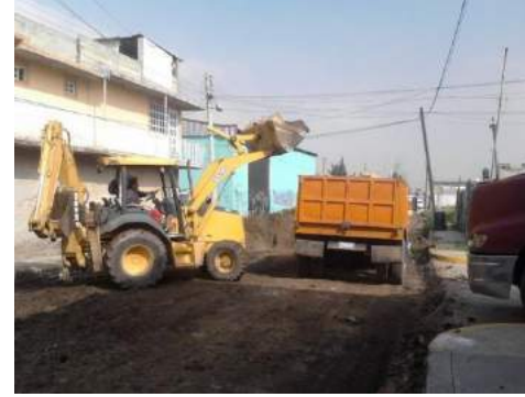
EXCAVACIÓN POR MEDIOS MECÁNICOS PARA ALCANZAR NIVELES DE PROYECTO
