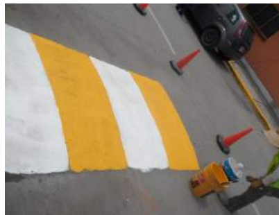
FABRICACIÓN DE REDUCTORES DE VELOCIDAD, PINTURA EN GUARNICIONES Y REDUCTORES DE VELOCIDAD.
