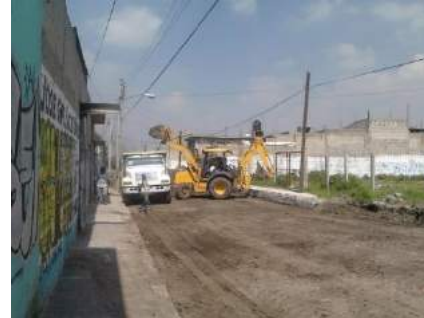
EXCAVACIÓN POR MEDIOS MECÁNICOS PARA ALCANZAR NIVELES DE PROYECTO
