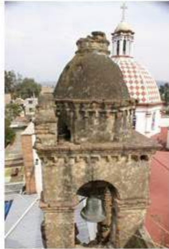
TORRE CAMPANARIO DEL XVI
