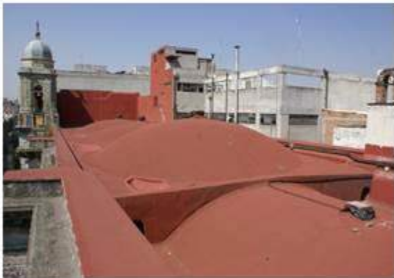
ESTADO DE CUBIERTAS PREVIO A LOS TRABAJOS
