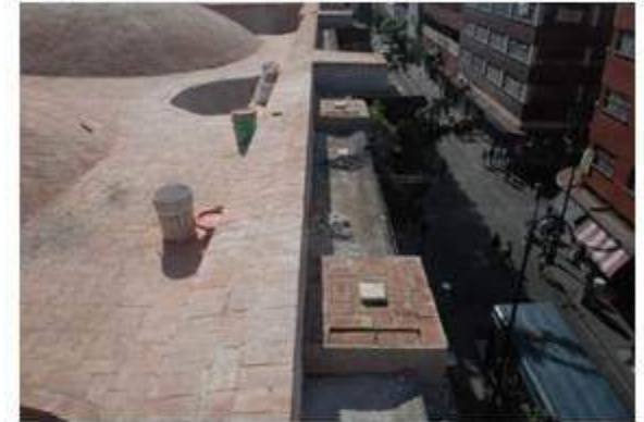
CUBIERTAS, PRETILES Y BASES DE PINACULOS ENLADRILLADOS
