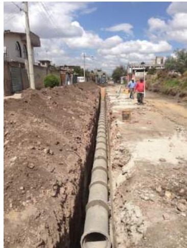
SUMINISTRO Y COLOCACIÓN DE TUBO DE ALBAÑAL
