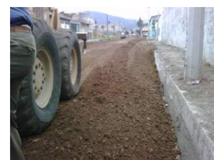
CONFORMACIÓN Y COMPACTACIÓN CON MATERIAL PRODUCTO DE BANCO (TEPETATE) POR MEDIOS MECÁNICOS
