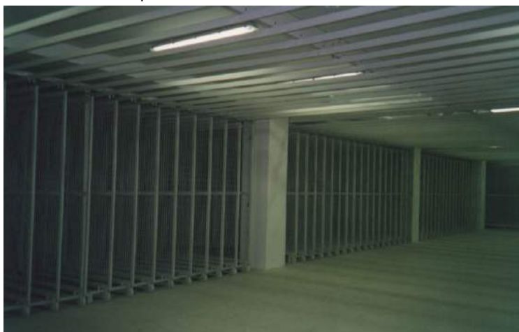
Instalación de 79 mamparas dobles sin cerramiento. Con una superficie de 1.850 m 2 . A dos caras 3.700 m 2 .
